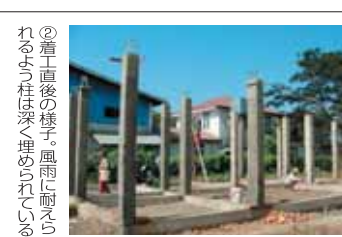
②着工直後の様子。風雨に耐えられないよう柱は深く埋められている。
